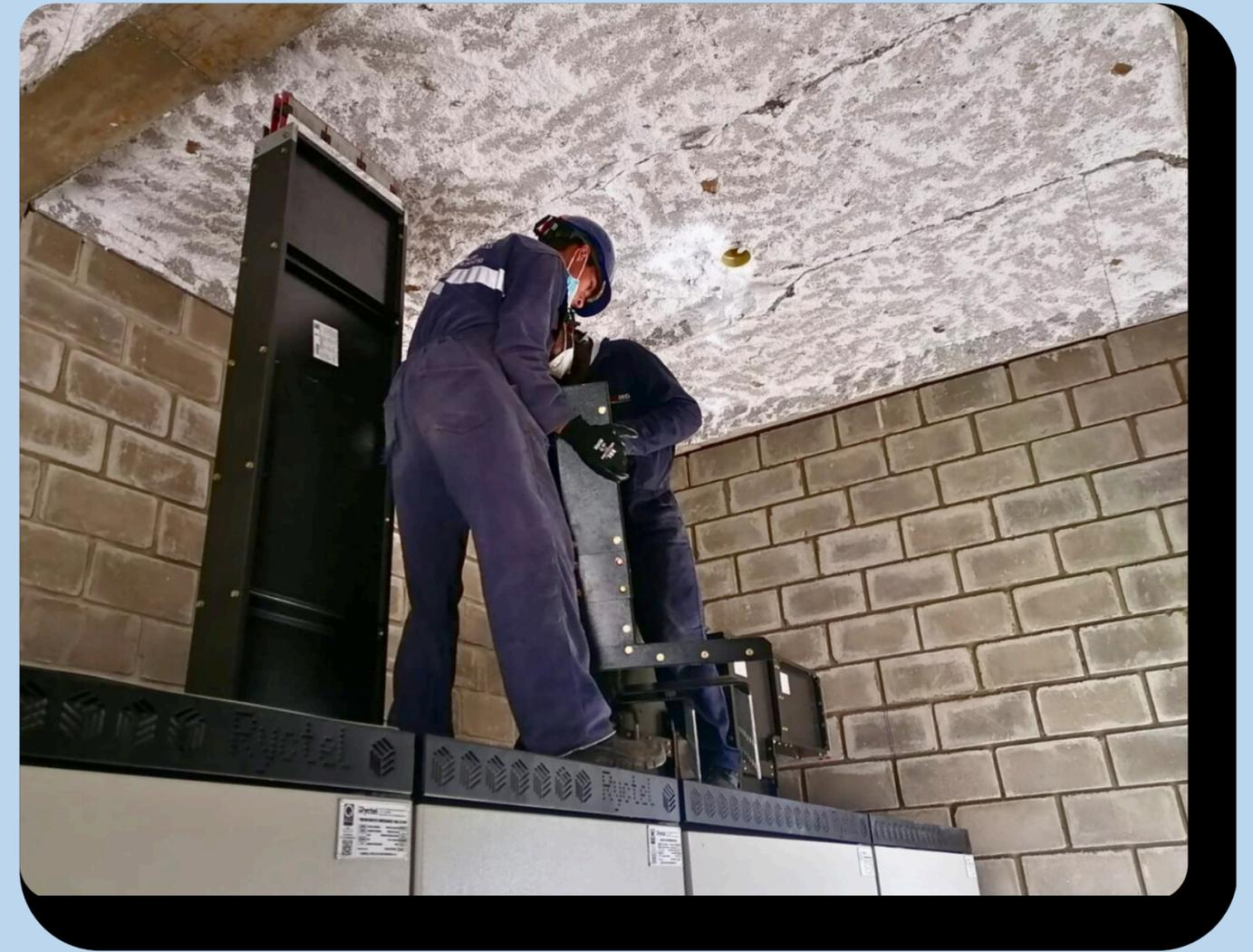
BARRANQUILLA - (Interconexión de transformador de 1,6 MVA /440 Vol, y 800 KVA / 220 Vol. en Electroducto 2.500 Amp.; y distribución en 2.500 y 630 Amp.
