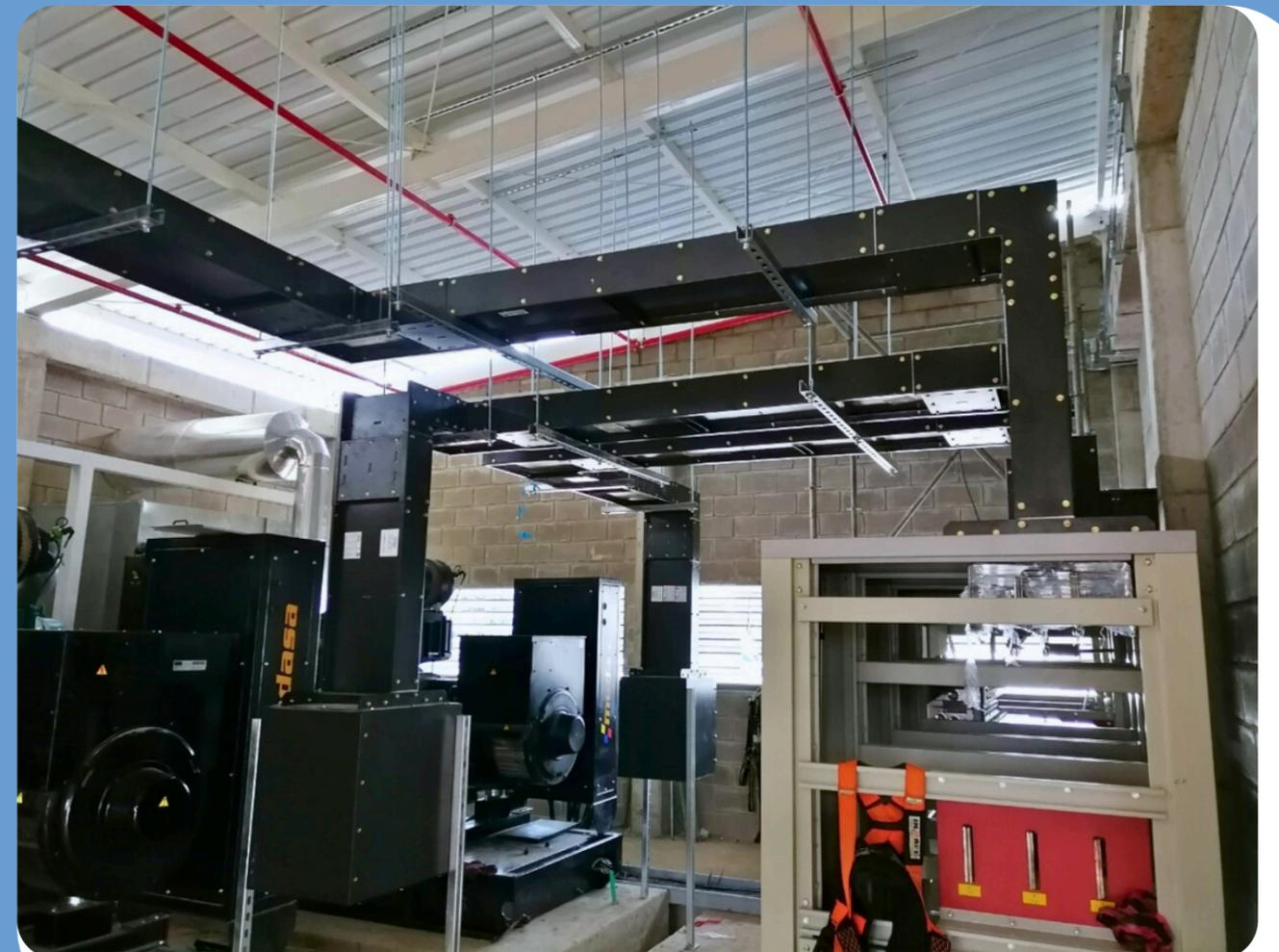
MAHATES - (Interconexión de la subestación y generación con electroductos de 5.000 Amp; distribución en planta con electroducto de 3.200 Amp.)
