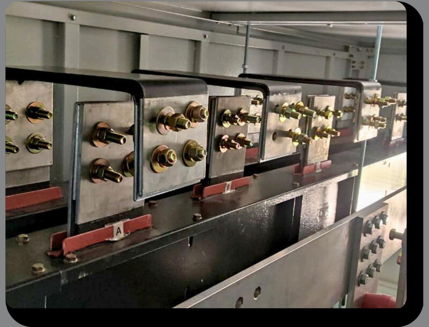
CARTAGENA – ( Interconexion de 2 subestaciones de 3,0 MVA en electro ducto de 4.000 Amp; y distribución en planta 270 metros de electroducto 1.600 Amp. )
