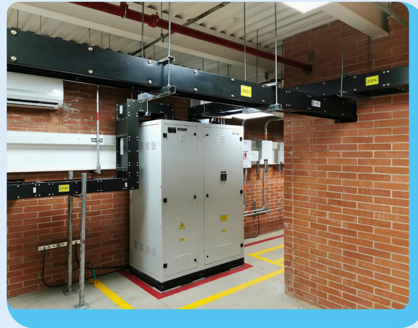
CENTRO DE PRODUCCIÓN DE ALIMENTOS DE CAMPO RUBIALES (Electroductos alimentador y distribución de 2.500, 1.250 y 630 Amp.) Interconexión de la subestación; y distribución a todos los equipos.
