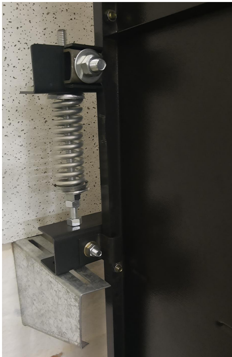
SOPORTE VERTICAL AMORTIGUADO MONTADO EN UN DUCTO
